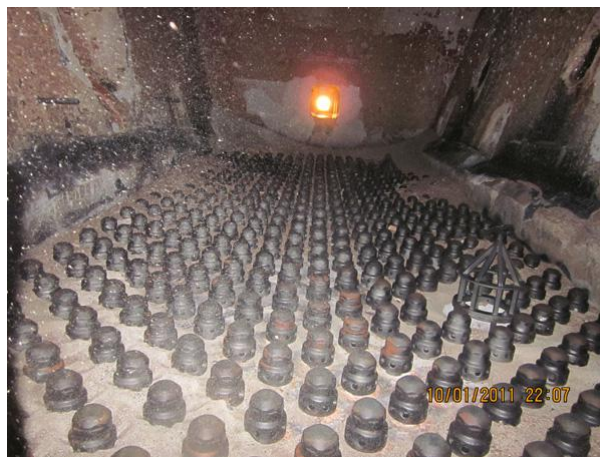
Gambar 2.17 Nozzle terpasang dalam Furnace (kiri) & F,A Nozzle Furnace (kanan)
