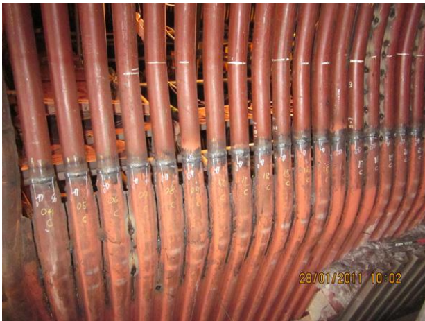
Gambar 2.51 Tubewall (kiri) & Penampang Tubewall (kanan)
