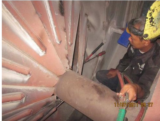
Gambar 2.13 Perbaikan Blade damper (vane)
