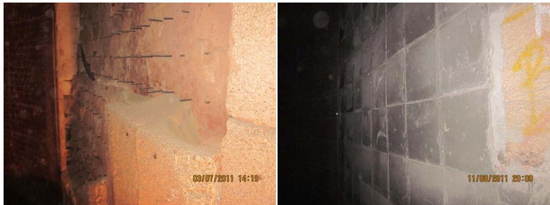
Gambar 2.31 Pengecekan refractory yg rusak(kiri) & Refractory yang telah diperbaiki
