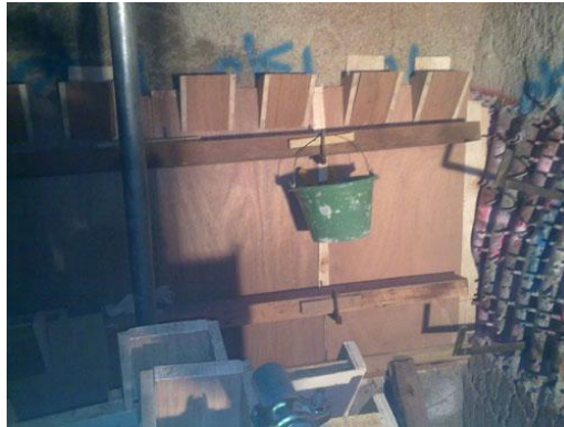
Gambar 2.24 Perbaikan Refractory Furnace
