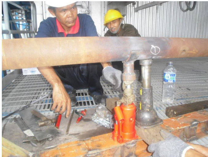
Gambar 2.46 Proses Pelurusan Lance Tube Soot Blower
