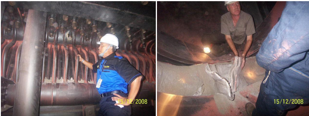
Gambar 2.26 Pengecekan area bottom plenum
