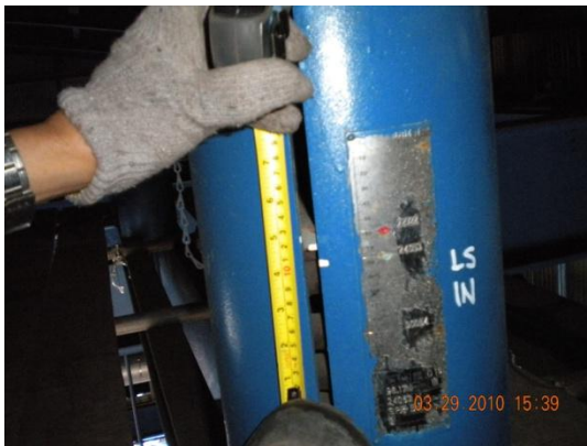
Gambar 2.25 Marking posisi hanger boiler sebelum & sesudah berbeban
