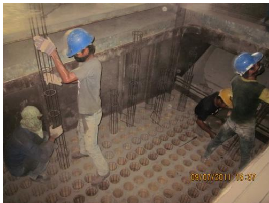
Gambar 2.48 Penggantian Bagfilter Baghouse
