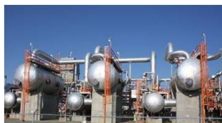
Contoh aplikasi surface condenser Pada Proses Claus untuk merecovery sulfur dari gas \text{H}_2\text{S}
